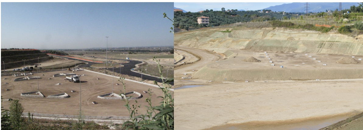
Fig. 37: Primi lavori di infrastrutturazione e sbancamento all'interno dell'area, Settembre 2011.
